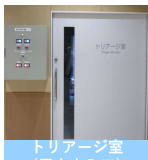
トリアージ室（屋内出入口）
